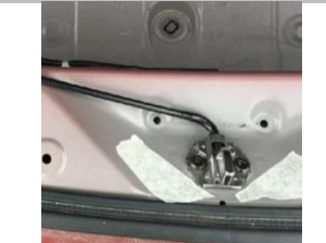
2.3 把我司拉门锁组主体用两件异形螺栓安装到原车拉耳位置，先预计紧，调好尾门间隙后再拧紧；
