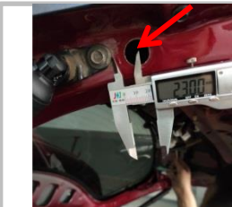
1.8 电机穿线：如上图位置钻 \phi 19 的孔，撑杆线束穿过，胶塞卡紧并用封口胶封口；左右两边同样安装
