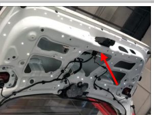
2.11 接门锁信号线：拆下盖板后，看到原车门锁连接器（4pin），所接信号线在连接器中；
